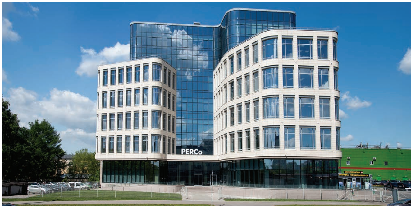
Главный офис PERCo
